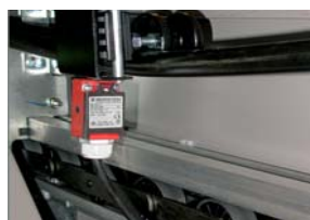
Системы безопасности – контроллер поломки поручней
